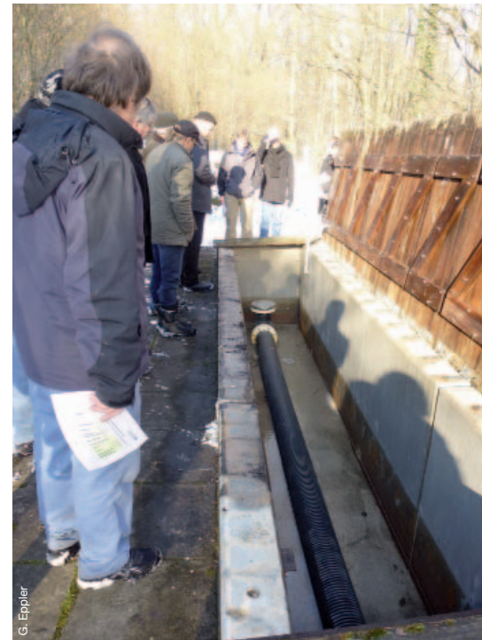
Besichtigung einer Anlage zur Grundwasserversickerung im Jägersburger Wald
